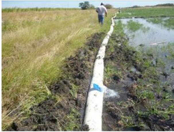
Sistema tradicional de regulación de agua para riego (sistema Parshal).vs. sistema de regulación del riego por tubería flexible
